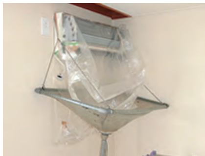
養生（洗浄準備）
