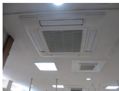
組立て～作業完成
