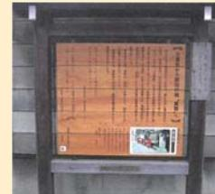
施工後9年経過していますが、サイン面に色あせは見られません。黒くなった枠にはAAC及び、木材防腐剤処理をしています。
